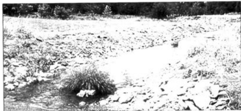
Travaux de stabilisation des berges à la Ferme Marita de Sainte-Edwidge-de-Clifton sur un des affluents de la rivière Ascot (aux Saumons).
